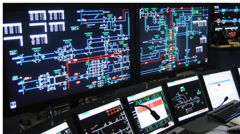
Fig. 1: Un centro per il controllo del traffico ferroviario equipaggiato con il sistema ICONIS di Alstom Ferroviaria
