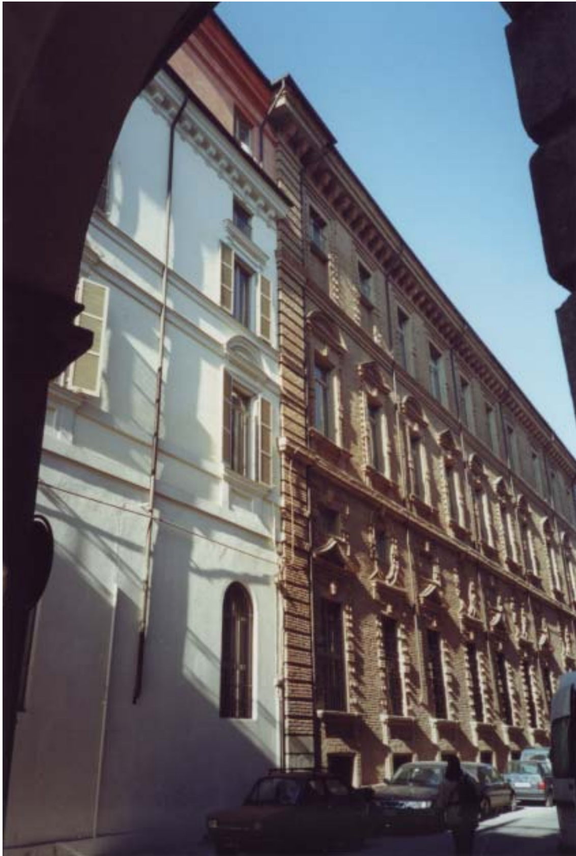
Fig. 7. Palazzo dell'Università, prospetto esterno su via Vasco. Il diverso trattamento (ad intonaco ed a mattoni) della cortina esterna evidenzia la non coincidenza dei piani (Foto Rita Binaghi).
