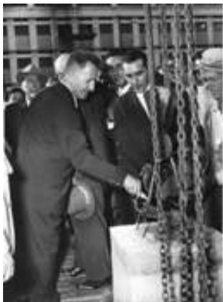
3. Posa della prima pietra dell'Istituto da parte del prof. Merlin (30-5-1959). In secondo piano a sinistra il ministro della pubblica istruzione on. Medici.
