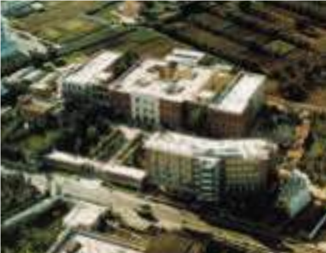
36. Veduta aerea del padiglione di Agraria e del collegio internazionale (Istituto agronomico mediterraneo, anni '60).
