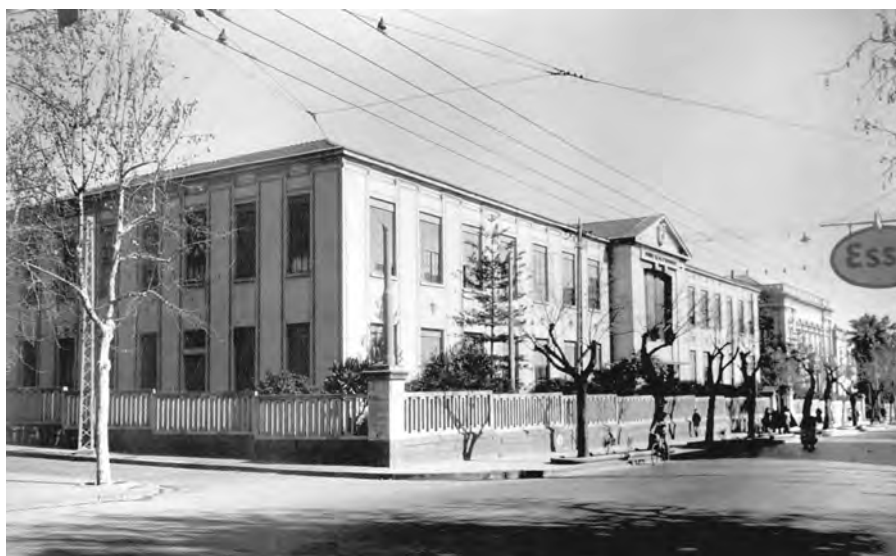
1. Regio Istituto tecnico-industriale, Catania.
