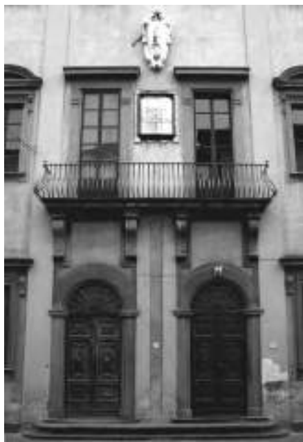
5. Facciata della seconda sede dell'Istituto chimico pisano; l'edificio ospita ora la Domus Galilaeiana.
