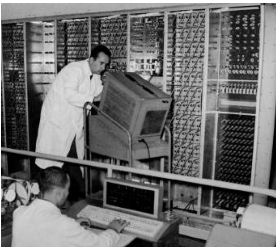
Istituto di fisica. La Calcolatrice Elettronica Pisana (CEP).
