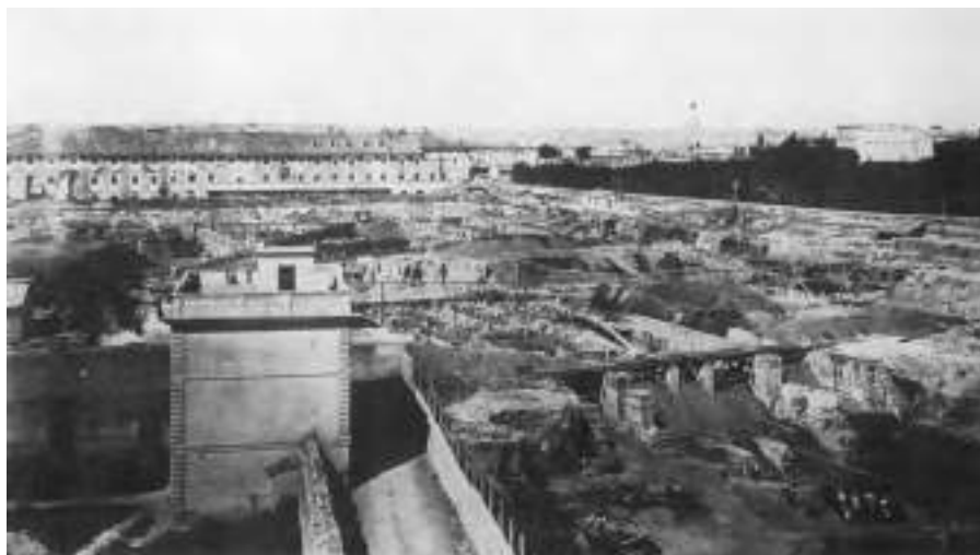
24. Veduta del cantiere del Ministero delle Finanze a Roma. Biblioteca del Ministero dei Lavori Pubblici, Roma.
