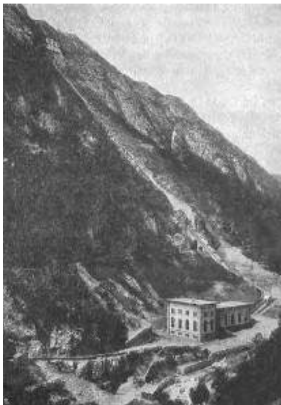
7. Centrale del Ponale, esterno.
