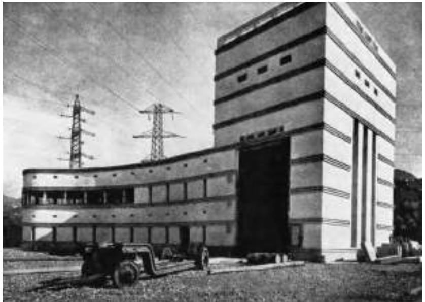
14. La Stazione di Trasformazione di Morigallo-Genova.
