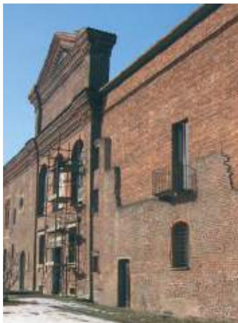
Cà Grandà, fronte su via Francesco Sforza – a destra la parte ricostruita
