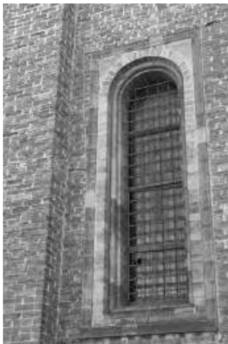
17. Milano, Santa Maria al Casoretto, particolare di un serramento.
