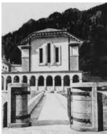
12. La centrale di Ponte in Castelfino-Cuneo, Val Formazza.
