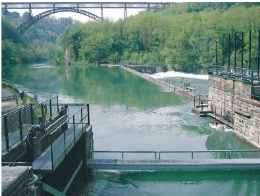
Veduta attuale dell'incile del canale di Paderno d'Adda per l'alimentazione della centrale idroelettrica "Angelo Bertini", 1898. Sullo sfondo il ponte, 1889
