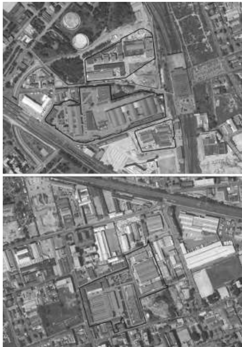
14. Veduta aerea del Campus in via Durando (Facoltà di Architettura Civile e Facoltà del Design) e del Campus in via La Masa-Lambruschini (Facoltà di Ingegneria Industriale): gli edifici a nord (ex area Broggi) sono ancora in costruzione, quelli a sud (ex area Origoni) sono già ultimati.
