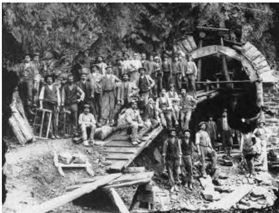
8. Foto di gruppo degli operai nel cantiere della galleria elicoidale di Varzo per il passaggio ferroviario del Sempione, a inizio Novecento. Foto Trabucchi, collezione privata.
