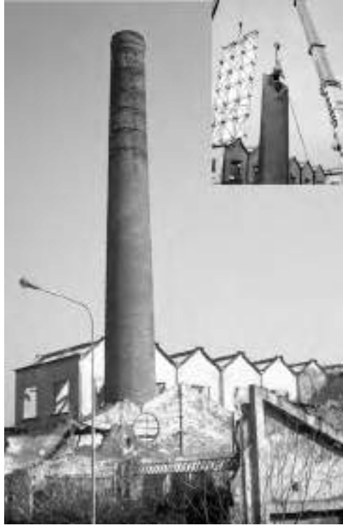
11. La ciminiera della Sirio prima (1997) e durante la demolizione avvenuta nel 2003.
