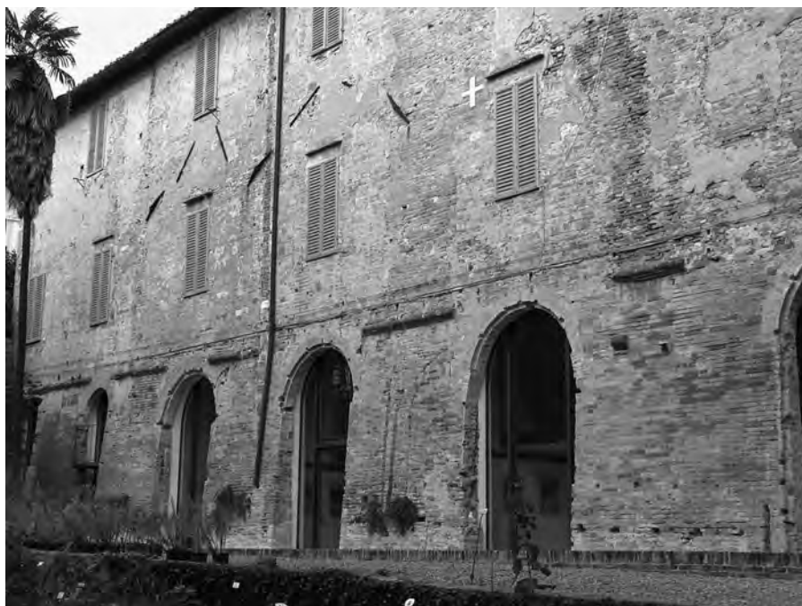
12. Retro della sede dei Fisiocritici volta verso l'orto botanico. Le grandi finestre furono aperte dall'Università durante il 1800 per le stanze occupate dalla botanica (foto Cancelli).
