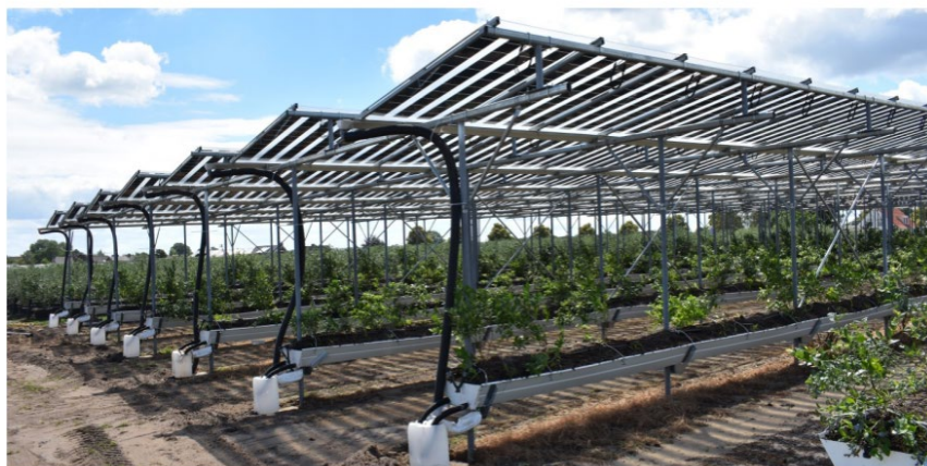
Fig. 7 Sistemi di raccolta di acqua piovana in un impianto agrivoltaico 10
